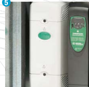
Nowy moduł napędowy o zmiennej prędkości obrotowej (VSD)
